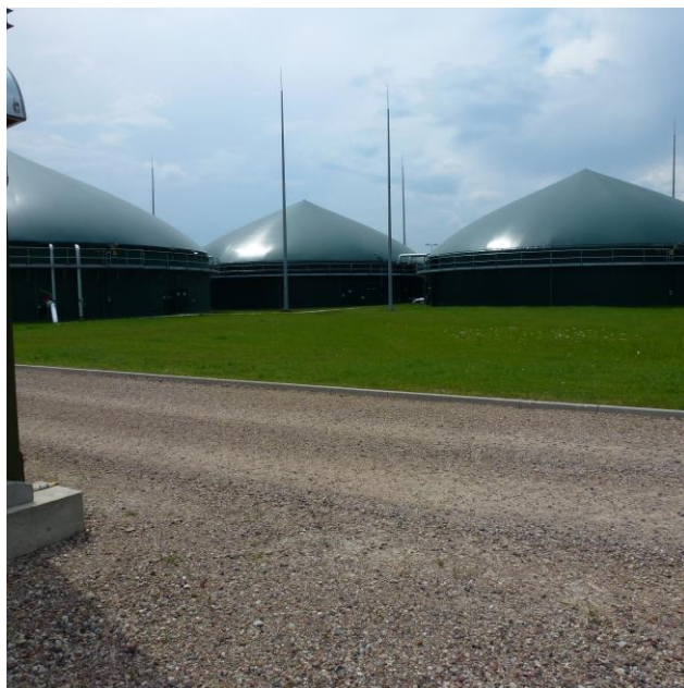
Zbiorniki fermentacyjne biogazowni rolniczej (wstępny, właściwy i gromadzący poferment) – Biogazownia rolnicza w Rybołach k/Białegostoku
